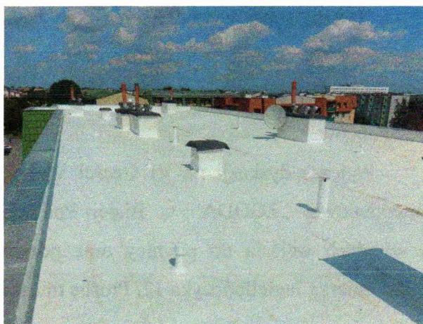
Rys. 10 Księcia Witolda 10 – remont pokrycia dachu hydronylonem
