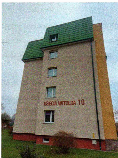
Rys. 9 Księcia Witolda 10 – docieplenie ściany szczytowej od strony północnej
